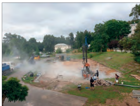
Na vrtání do skály musela být použita zvláštní technika
