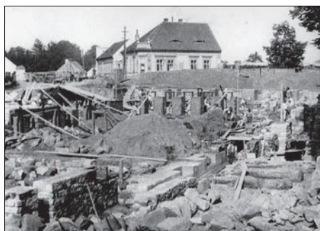
Záběr ze stavby (pracovalo se většinou svépomocí)
