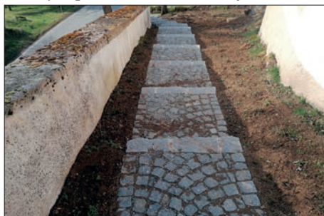
BEZDĚDOVICE-PAŠTIKY - Pohled na nové schodiště směr Paštiky
