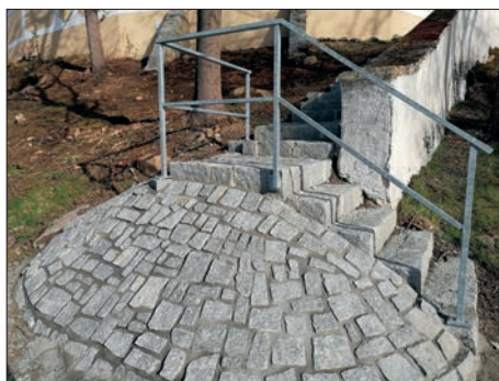
BEZDĚDOVICE-PAŠTIKY - Pohled na nové schodiště se zabezpečením proti pádu a kamenným obložení skalního výběžku
