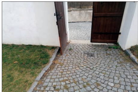
BEZDĚDOVICE-PAŠTIKY - Plynulé navázání dláždění nového schodiště na chodník v areálu hřbitova
