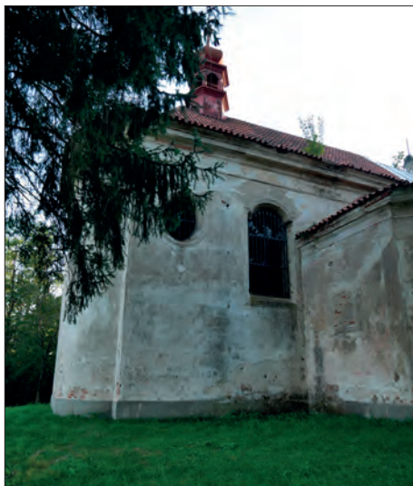
Kostel Proměnění Páně, Křesovec u Pacelic, 1763 - 1765, pohled od severovýchodu, foto - Cimler
