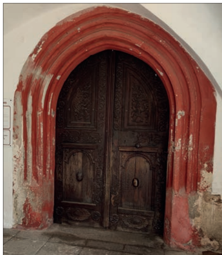
Před opravou v roce 2022
