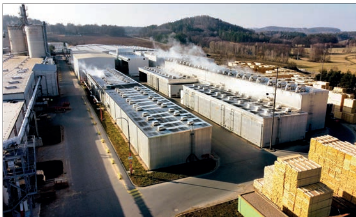
Díky novým, efektivnějším sušicím komorám bude brzy možné sušit až 450 000 m 3 řeziva ročně
