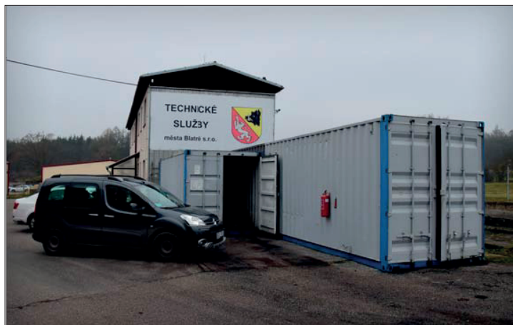
Pro skladování odpadových nádob nebo menší techniky se osvědčily vyřazené námořní kontejnery o objemech od 33 a 67 „kubiků“. Jsou uzamykatelné s uvnitř instalovaným osvětlením
